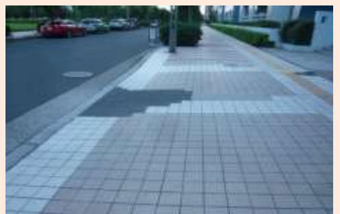
アスファルトで石畳を補修
