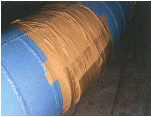
ガムテープで輸送管を補修（つくば市）
