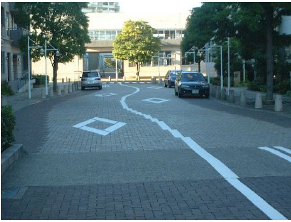
中央分離線を曲線にして、車の速度を落とす工夫
